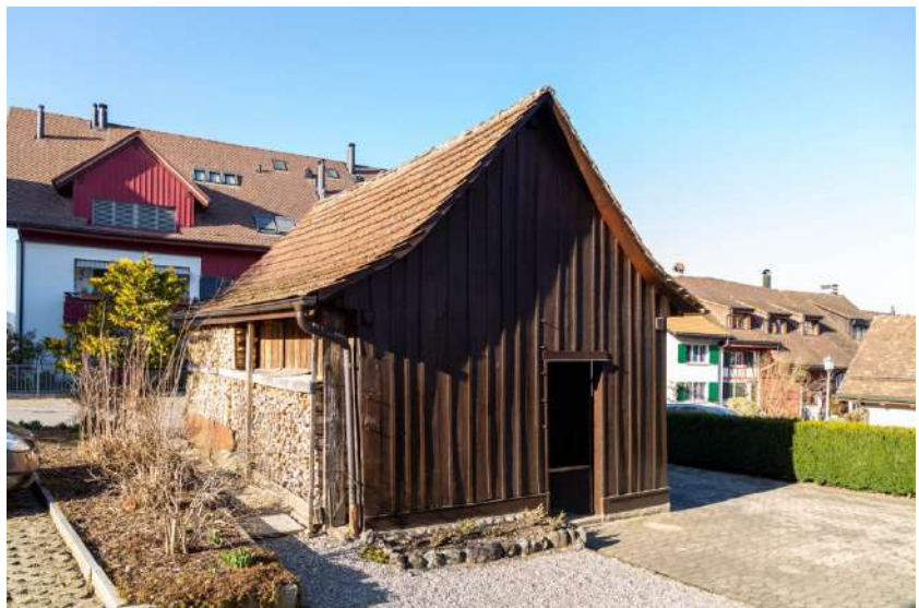
Ansicht von Süden (Bild SKW)
