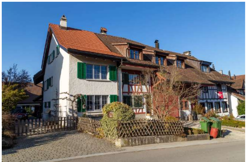
Ansicht von Süden (Bild SKW)
