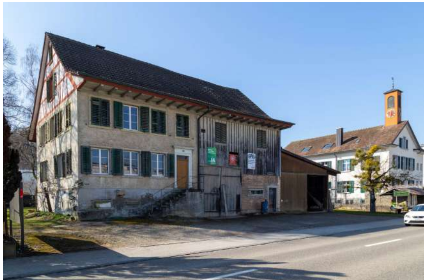
Ansicht von Nordosten (Bild SKW)
