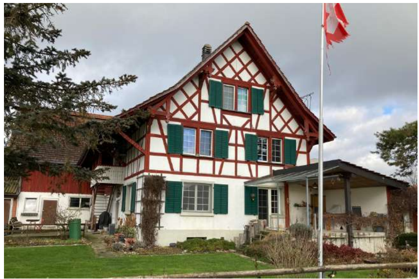
Ansicht von Süden (Bild SKW)
