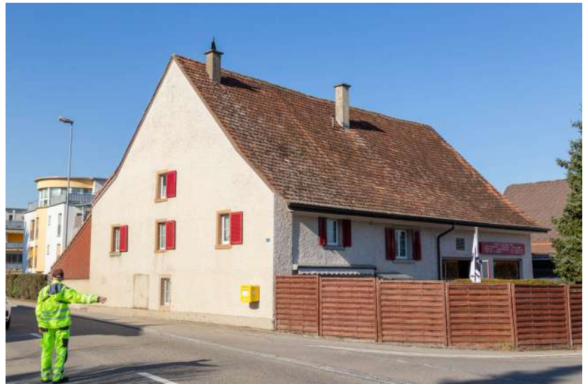
Ansicht von Süden (Bild SKW)
