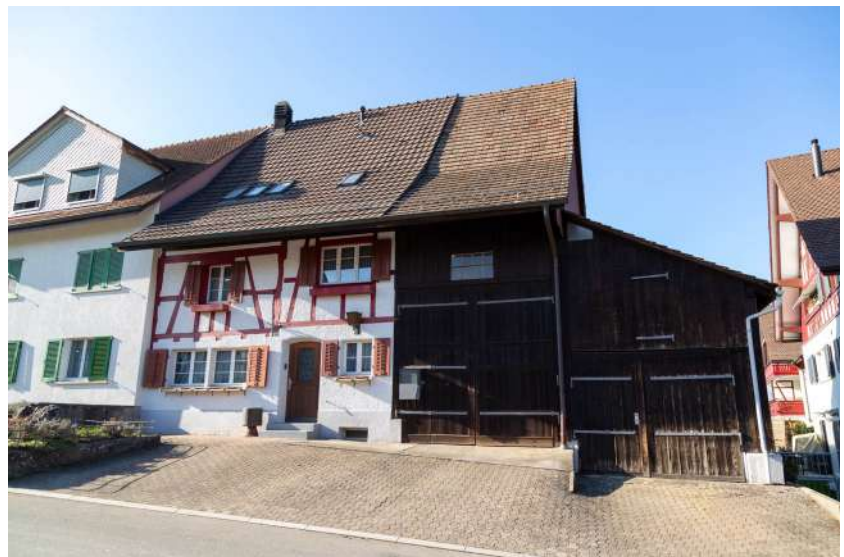
Ansicht von Südosten (Bild SKW)
