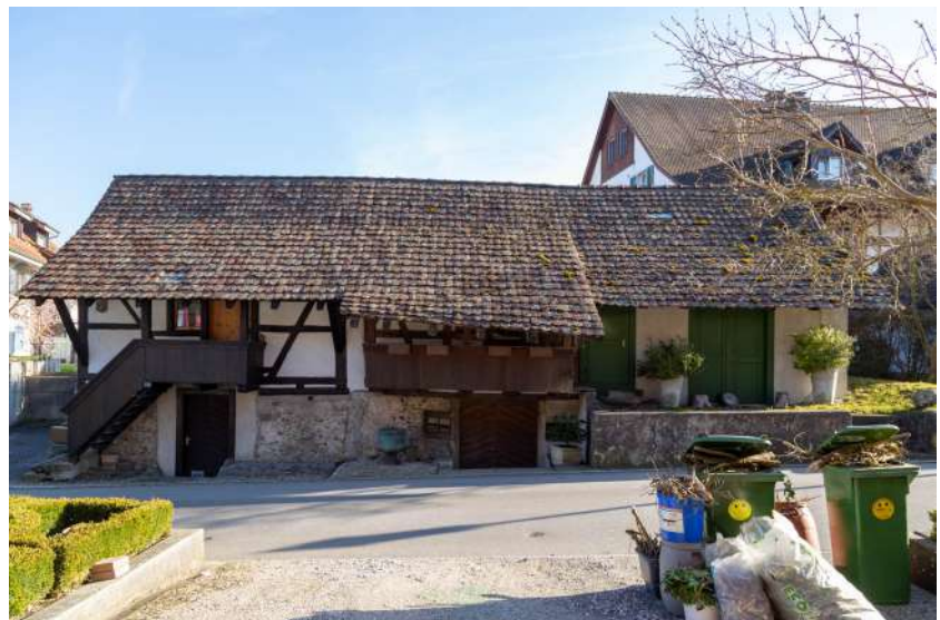
Ansicht von Norden (Bild SKW)
