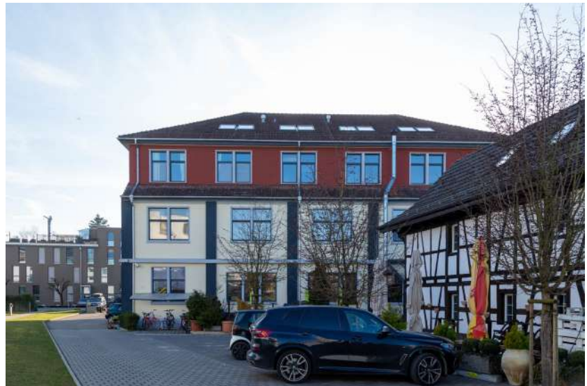
Ansicht von Nordosten (Bild SKW)
