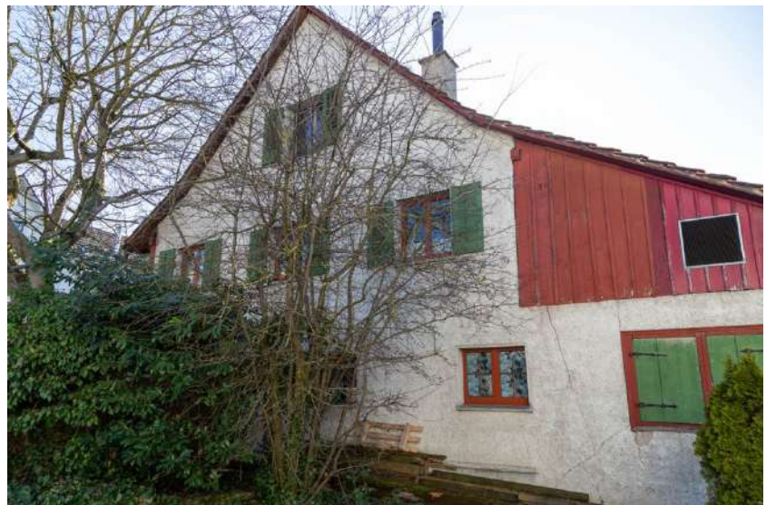
Ansicht von Nordosten (Bild SKW)
