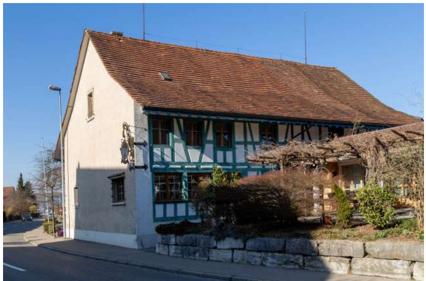
Ansicht von Süden (Bild SKW)
