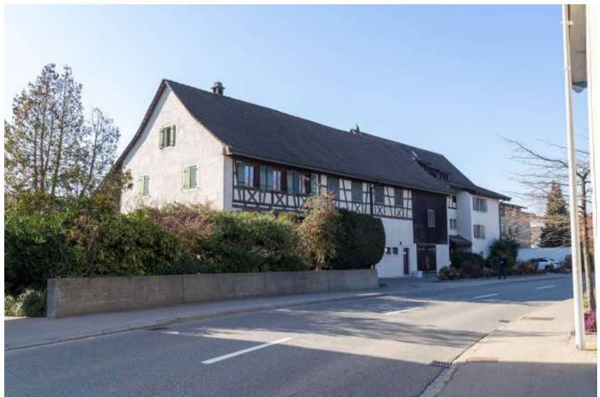
Ansicht von Südosten (Bild SKW)
