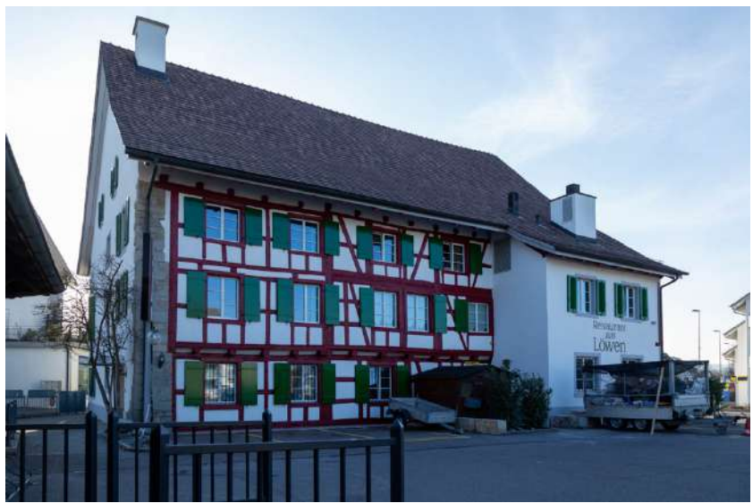
Ansicht von Nordosten (Bild SKW)
