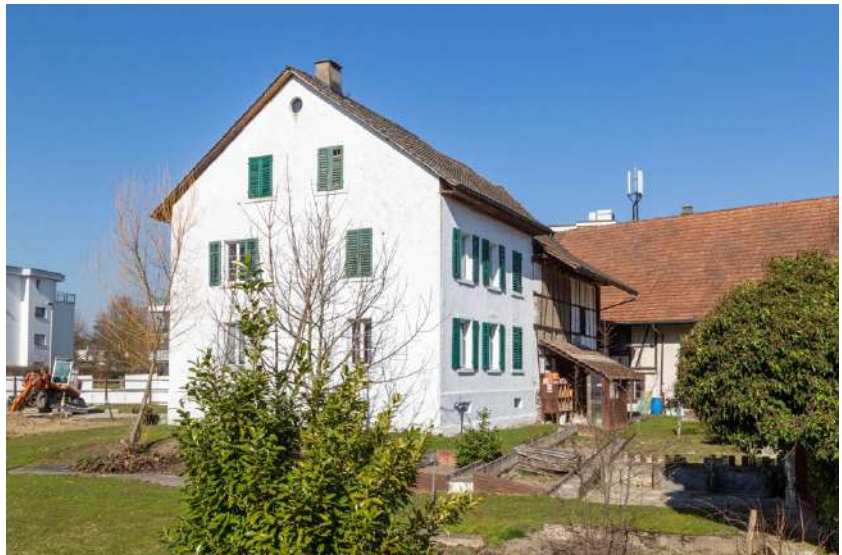
Ansicht von Süden (Bild SKW)
