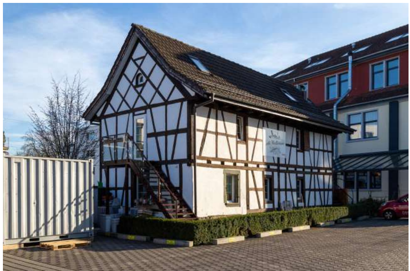
Ansicht von Norden (Bild SKW)
