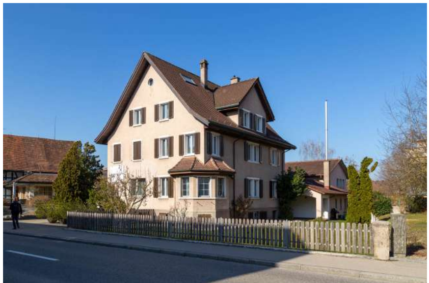
Ansicht von Süden (Bild SKW)
