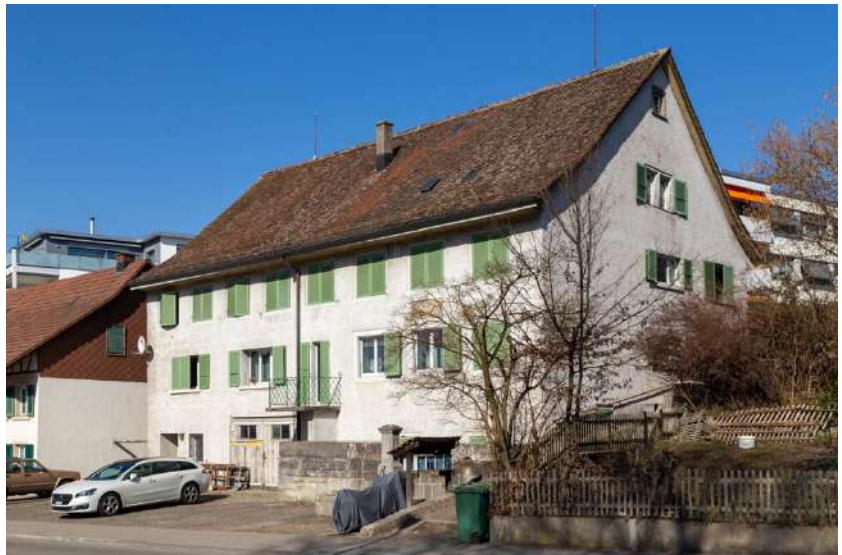
Ansicht von Süden (Bild SKW)
