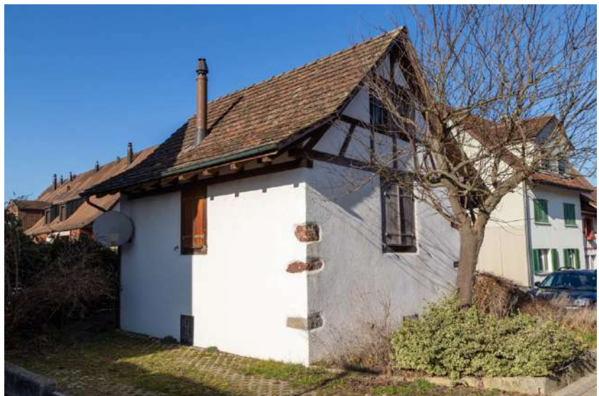
Ansicht von Süden (Bild SKW)
