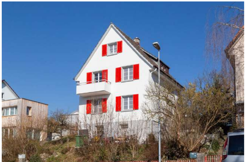
Ansicht von Süden (Bild SKW)
