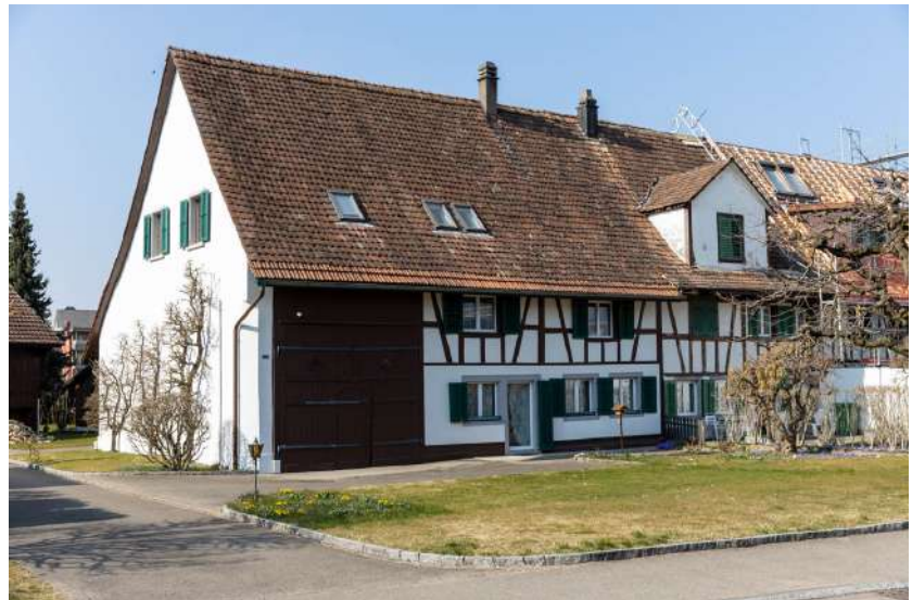
Ansicht von Süden (Bild SKW)
