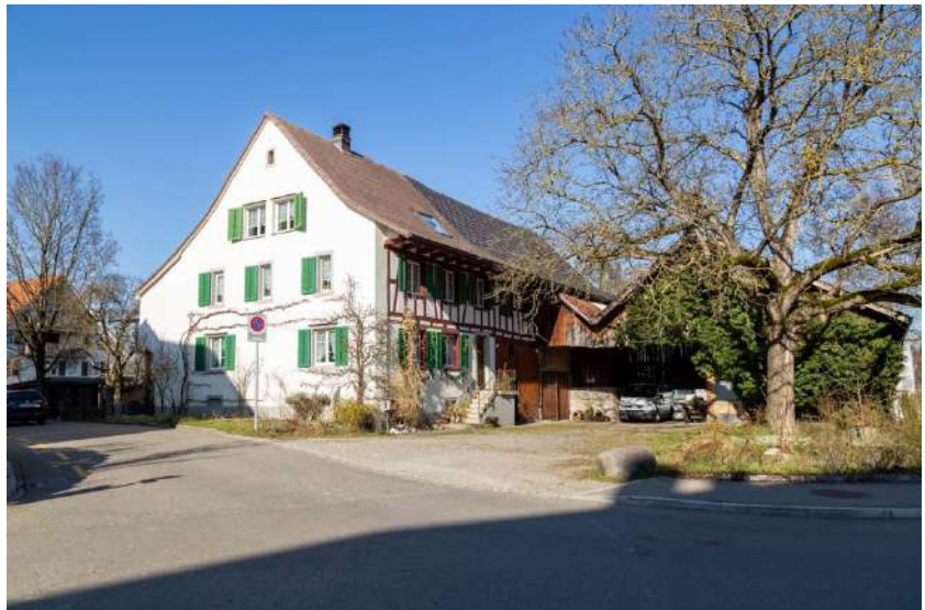
Ansicht von Süden (Bild SKW)
